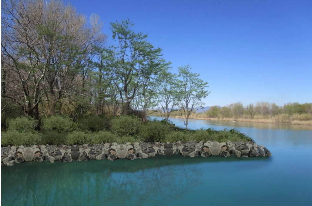
Figura 21– fotoinserimento intervento di ripristino del pennello a protezione della darsena
